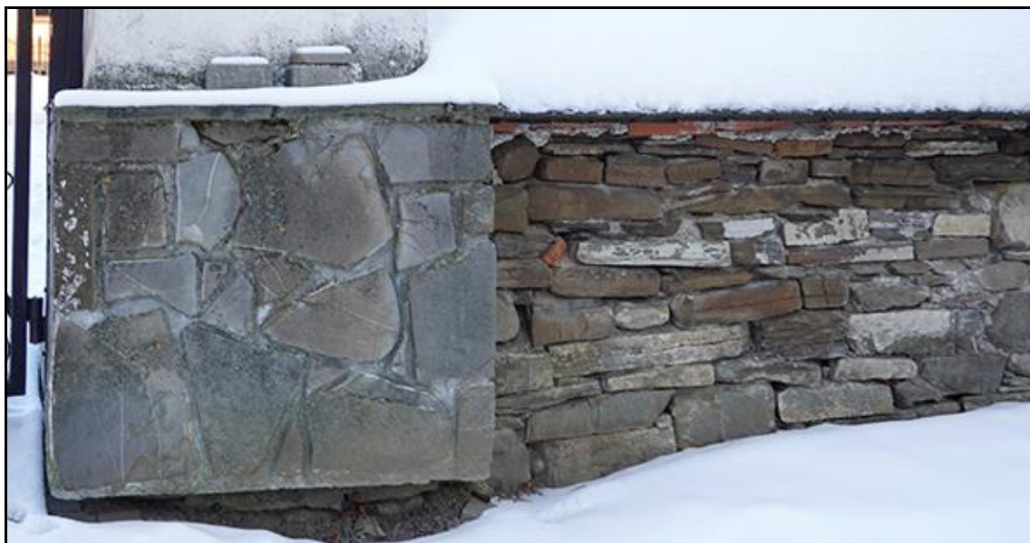
Fot. 7. Wątek kamienny muru, w dolnej partii filara omurowany płaskimi kamiennymi płytami odpadowymi. Celem tego omurowania było wzmocnienie dolnej partii filarów bramy.
