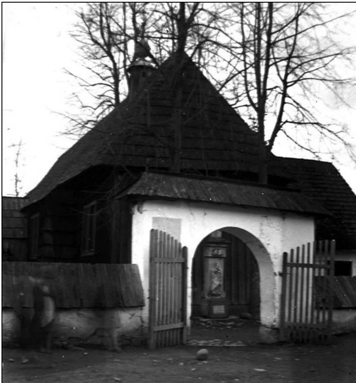
Fot. 4 Zdjęcie z lat 1930-1933, brak informacji o autorze. Na zdjęciu widoczna wcześniejsza forma bramy z półkolistym zamknięciem przejścia, gont na zwieńczeniu bramy wymieniony – zachowano formę, zastosowano dłuższe deski, bez dbałości o detal. Wokół bramy murowane ogrodzenie w obecnej formie, tynkowane.
