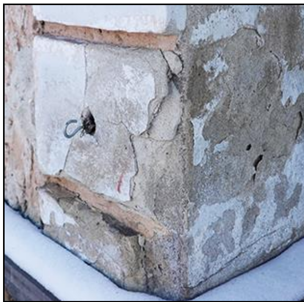
Fot. 7 i 8. Dolne partie filarów bramy. Widoczny efekt dezintegracji strukturalnej tynków, spowodowany migracją z gruntu w górę muru, soli rozpuszczonych w wodzie. Które w momencie odparowywania wody z powierzchniowych warstw tynku zwiększając swoją objętość w procesie krystalizacji, rozsadzają strukturę tynku.
