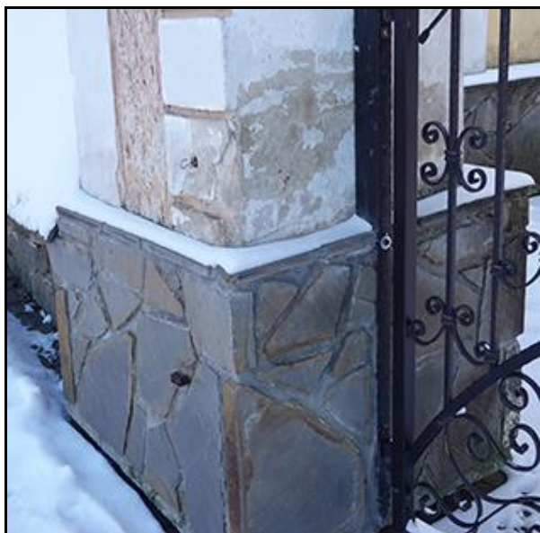
Fot. 7 i 8. Dolne partie filarów bramy. Widoczny efekt dezintegracji strukturalnej tynków, spowodowany migracją z gruntu w górę muru, soli rozpuszczonych w wodzie. Które w momencie odparowywania wody z powierzchniowych warstw tynku zwiększając swoją objętość w procesie krystalizacji, rozsadzają strukturę tynku.
