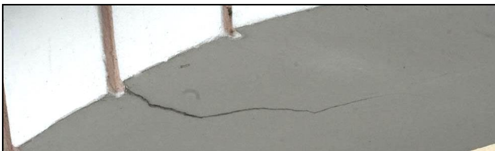
Fot. 9 Szczelinowe pęknięcie muru w partii nadproża w łuku zwieńczenia bramy oraz w filarze północnym
